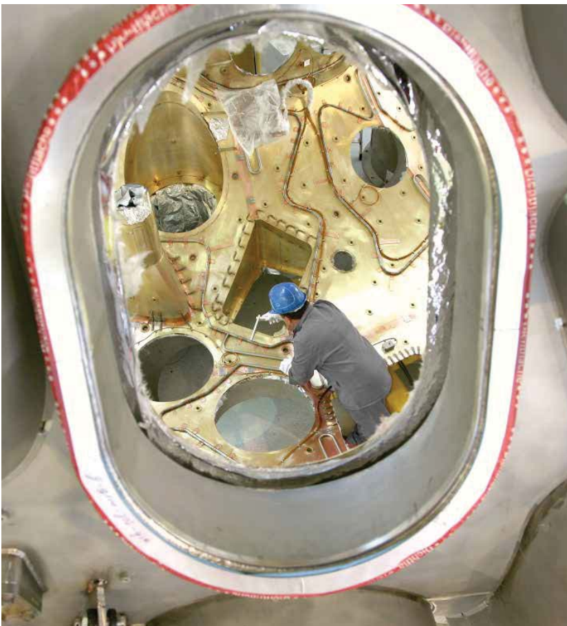
Ein Arbeiter in der Plasmakammer verkleidet die Wand mit Kühlpaneelen aus Edelstahl.
